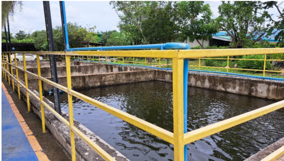
บ่อพักน้ำหลังบำบัดเสร็จแล้ว ก่อนปล่อยออก
