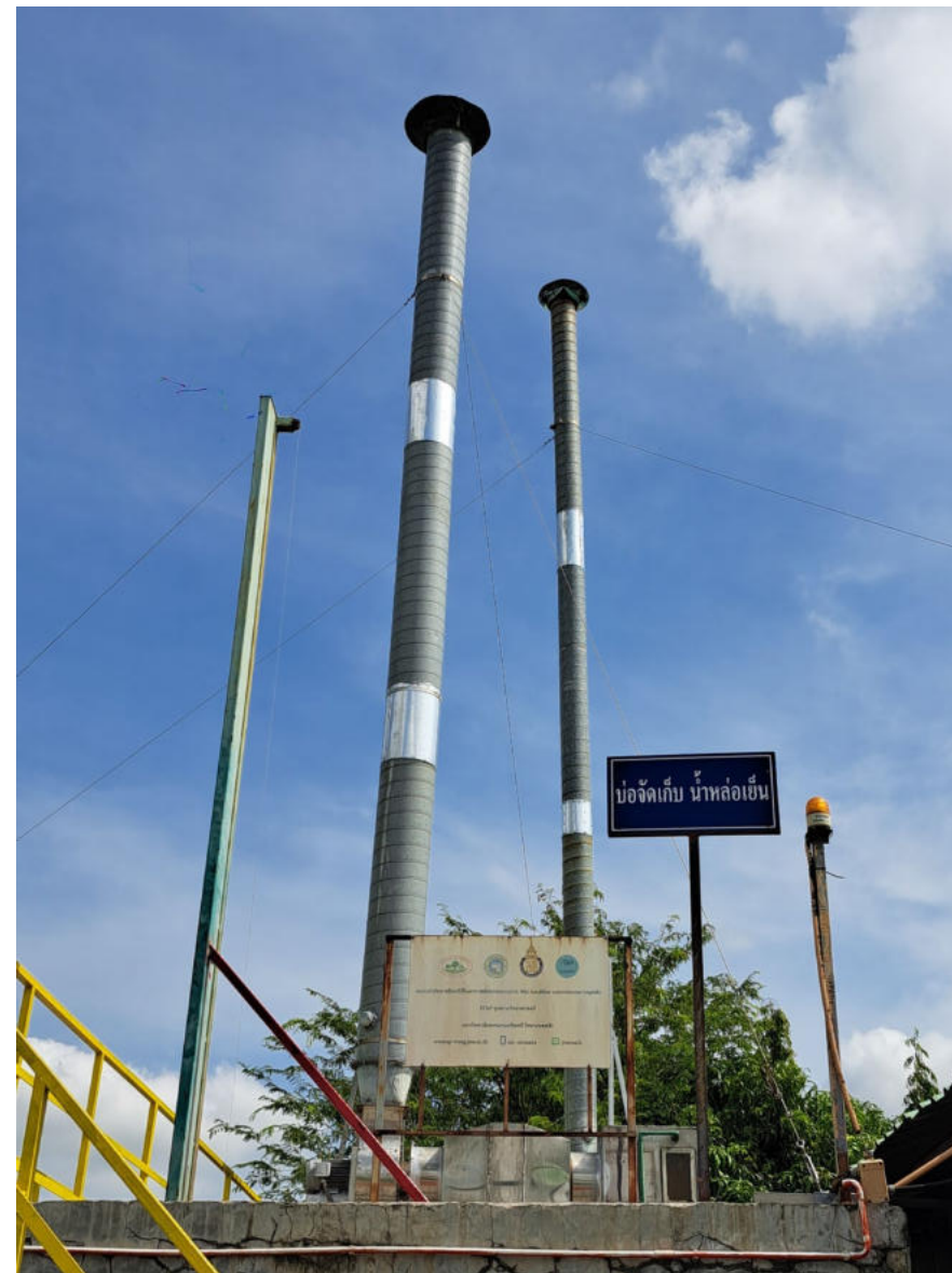
ระบบ Wet Scrubber และ Activated Carbon ทำหน้าที่ดักจับไอระเหยของน้ำเสีย
